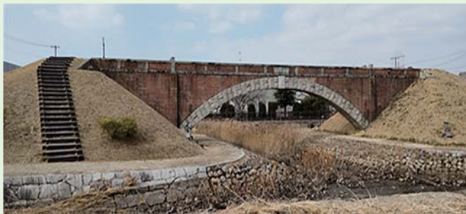
加古川市野口町水足 247 にある平木水路橋
